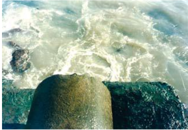
Fig. I-4: Eaux usées rejetées directement dans la mer (Alger)
