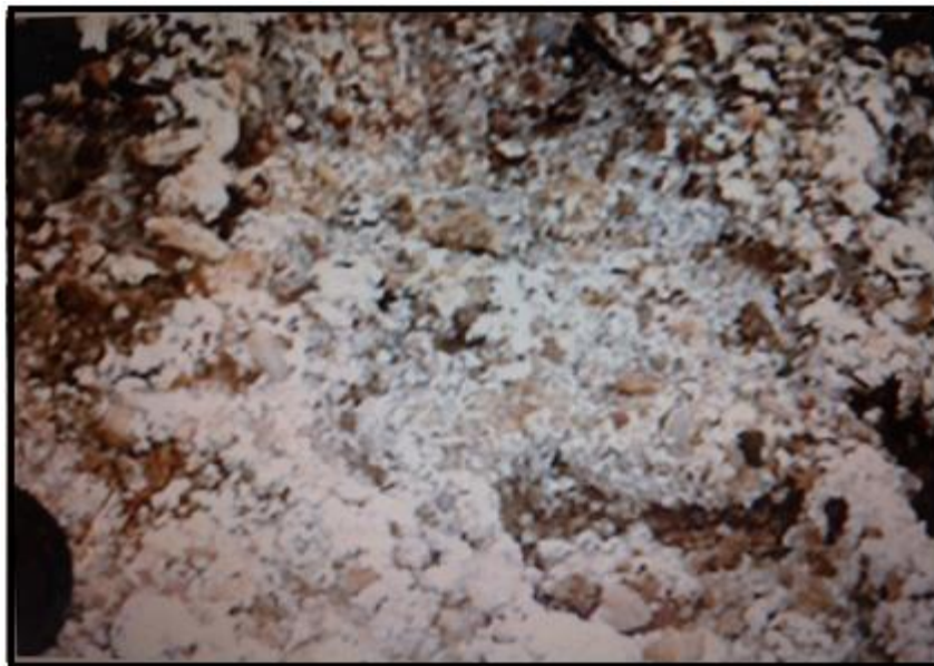
Fig. I-9 : Efflorescence saline à la surface d'un sol salé
