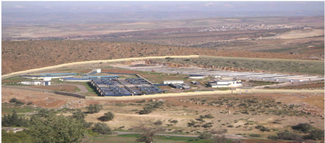
Figure I.10. Panoramique de la station d'épuration des eaux usées de la ville de Tlemcen.
