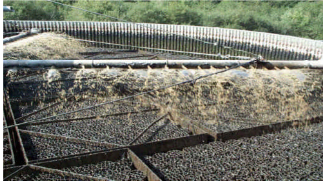
Figure II.3. Alimentation du lit bactérien (garnissage plastique) [62].
