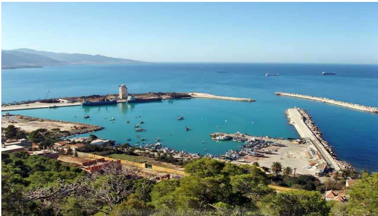
Figure III-1 : le port de Béni saf (willaya de Ain Témouchent).
