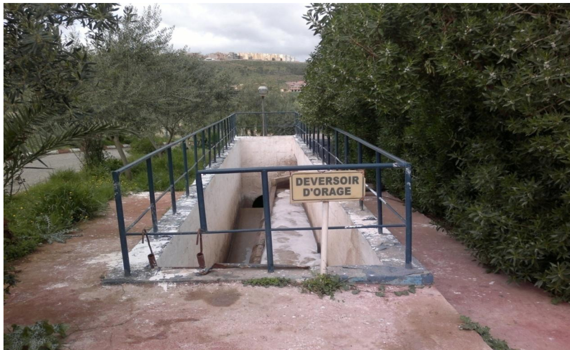
Fig. III.3 : Déversoir d'orage.
