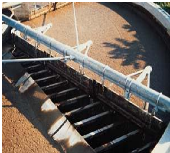
Fig. II.2 : Épaississement des boues par flottation [29].
