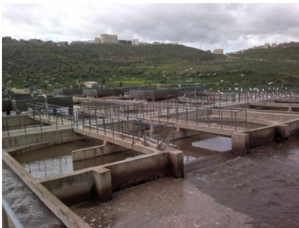
Fig. III.9 : Bassin d'aération
