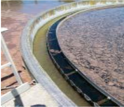
Fig. III.30 : Flottants de dénitrification en surface du clarificateur.
