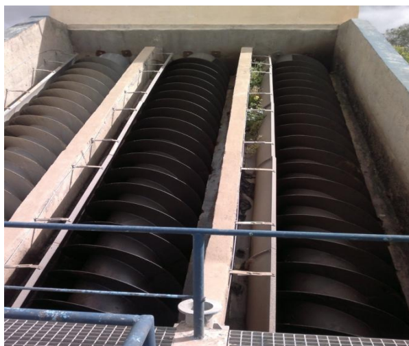
Fig. III.11 : Vis de recirculation (Vis d'Archimède).
