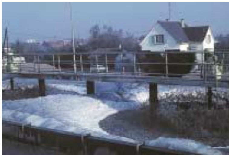
Fig. III.29 : Mousse blanche de détergents en surface de bassin d'aération [41].
