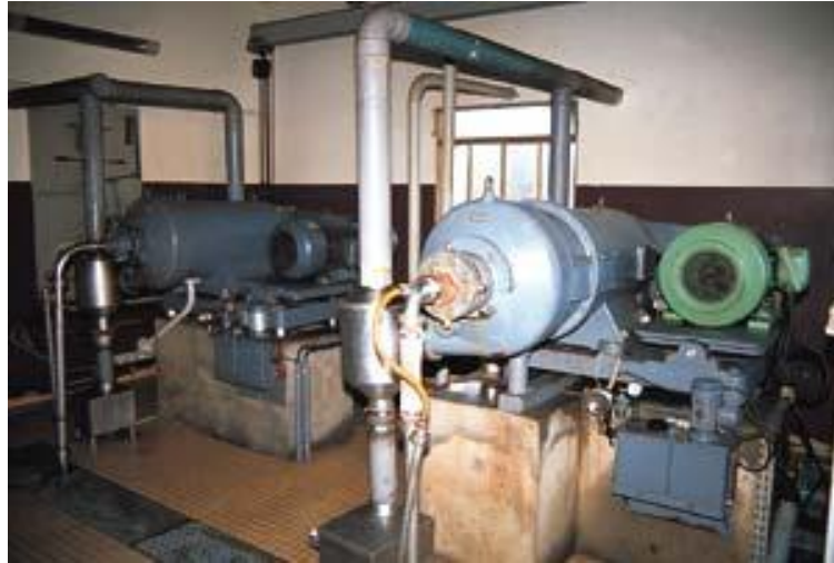
Fig. II.8 : Déshydratation des boues par centrifugation [28].
