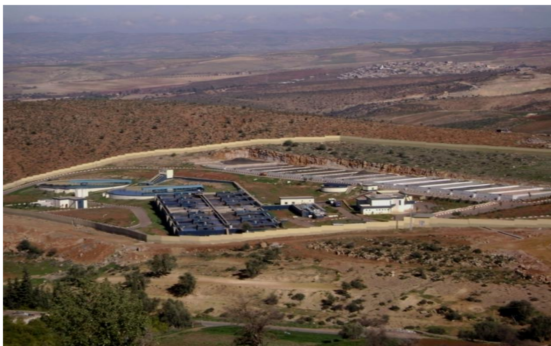
Fig. III.1 : Vue de la station d'épuration d'Ain El Houtz [11].
