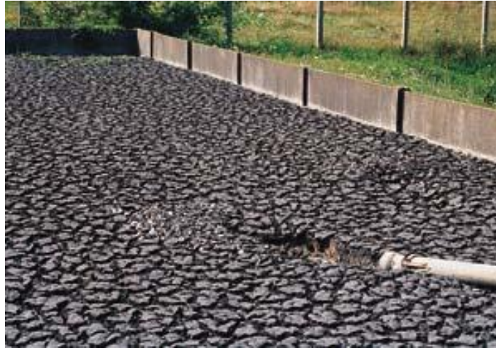
Fig. II.9 : lit de séchage naturel [29].
