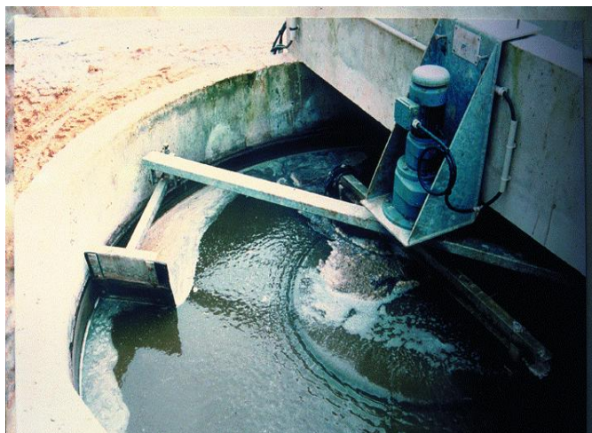
Fig. I.4 : Dessableur-dégraisseur circulaire (Source : Degremont, 2005).
