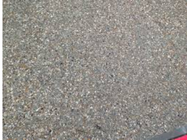
Béton désactivé : Usage pour l'intersection de deux espaces différents
