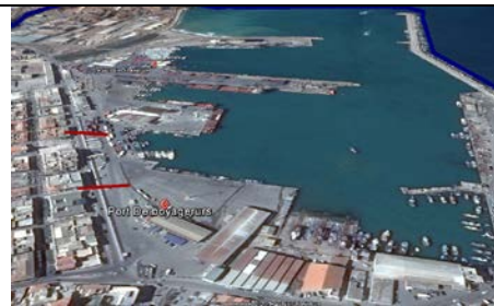
Figure 51:Le port de Ghazaouet est en relation directe avec le centre ville de Ghazaouet. 75
