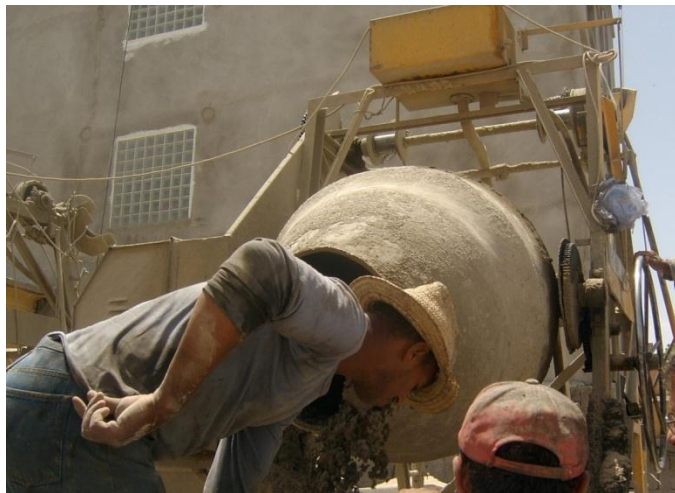
Figure III-1: bétonnières pour malaxage.
