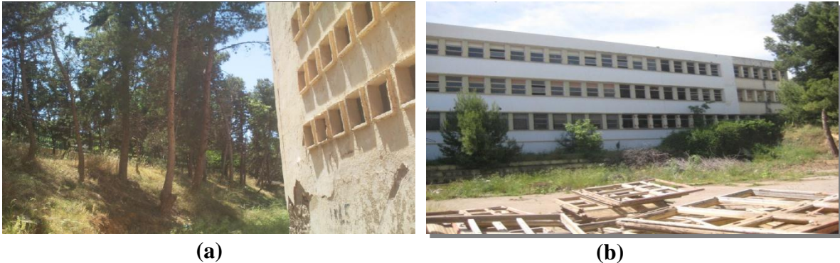
Figure 4.7 : La présence de végétation plus proche de bâtiment.
