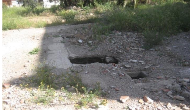
Figure 4.8 : La partie démolie.
