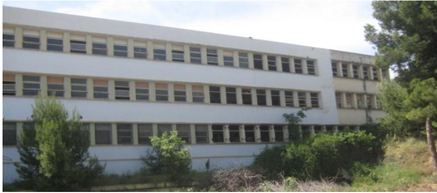
Figure 3.3 : Vue de l'architecture du bâtiment.
