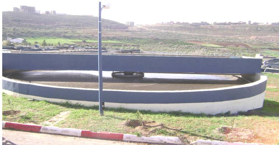
Figure V.11: Photo d'un épaississeur [48]
