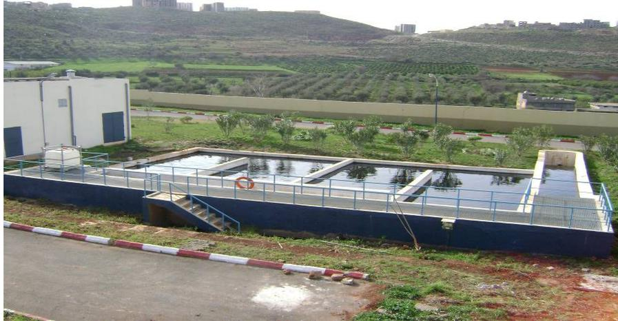
Figure V.10: Photo du bassin de chloration [48]
