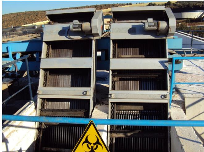
**Figure V.6:** Photo de la grille mécanisée [48]
