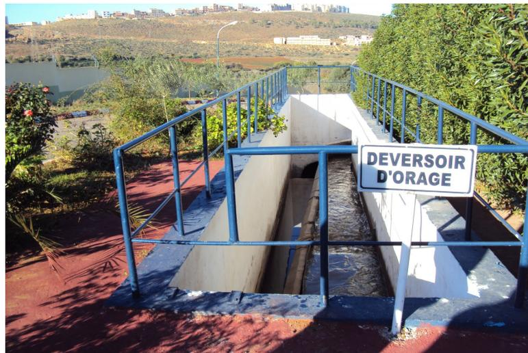
Figure V.4: Photo du Déversoir d'orage [48]
