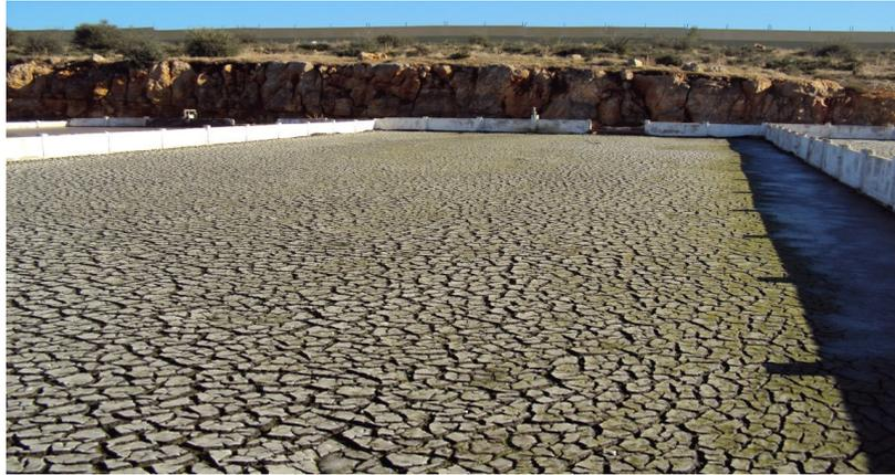
Figure V.12: Vue d'un lit de séchage rempli de boues
