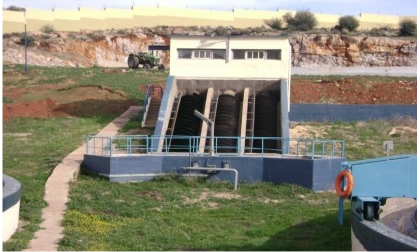
FigureII.8. : Vis de recirculation (vis d'Archimède)
