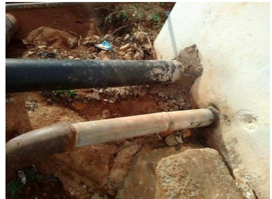
Fig.2.6 Conduite en acier enrobée 102/114
