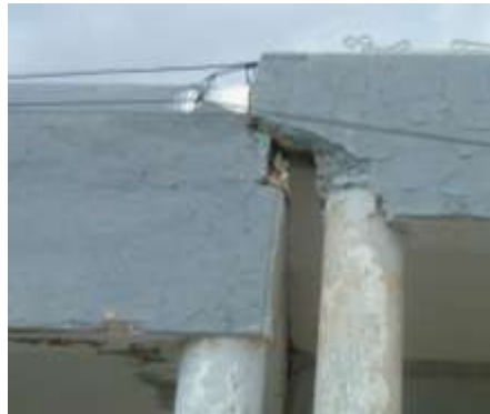
Figure 3.13 : Soulèvement du bloc à droite par rapport à l'autre bloc acoté.
