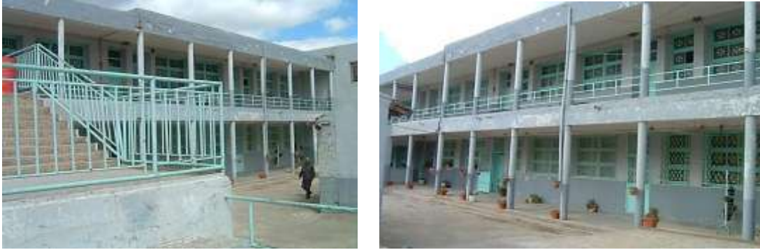
Figure 2.7 : Les façades principales des classes à l'intérieur du Cem.
