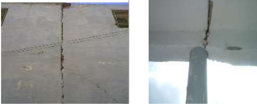
Figure 2.14 : L'ouverture du joint au RDC, premier niveau et à l'extérieur.
