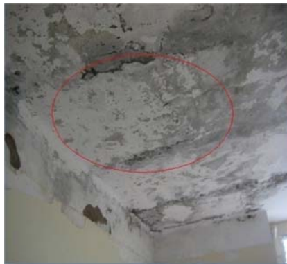
Photo II-5: Problème d'étanchéité.
