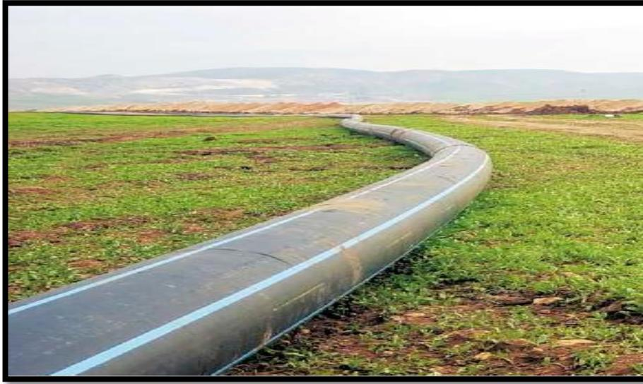
Figure N°13: Tube en PE arien.
