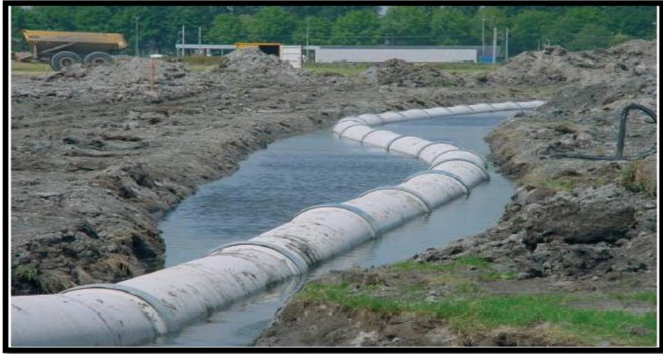
*Figure N°5: Canalisation en fonte ductile revêtue extérieurement en mortier de ciment*
