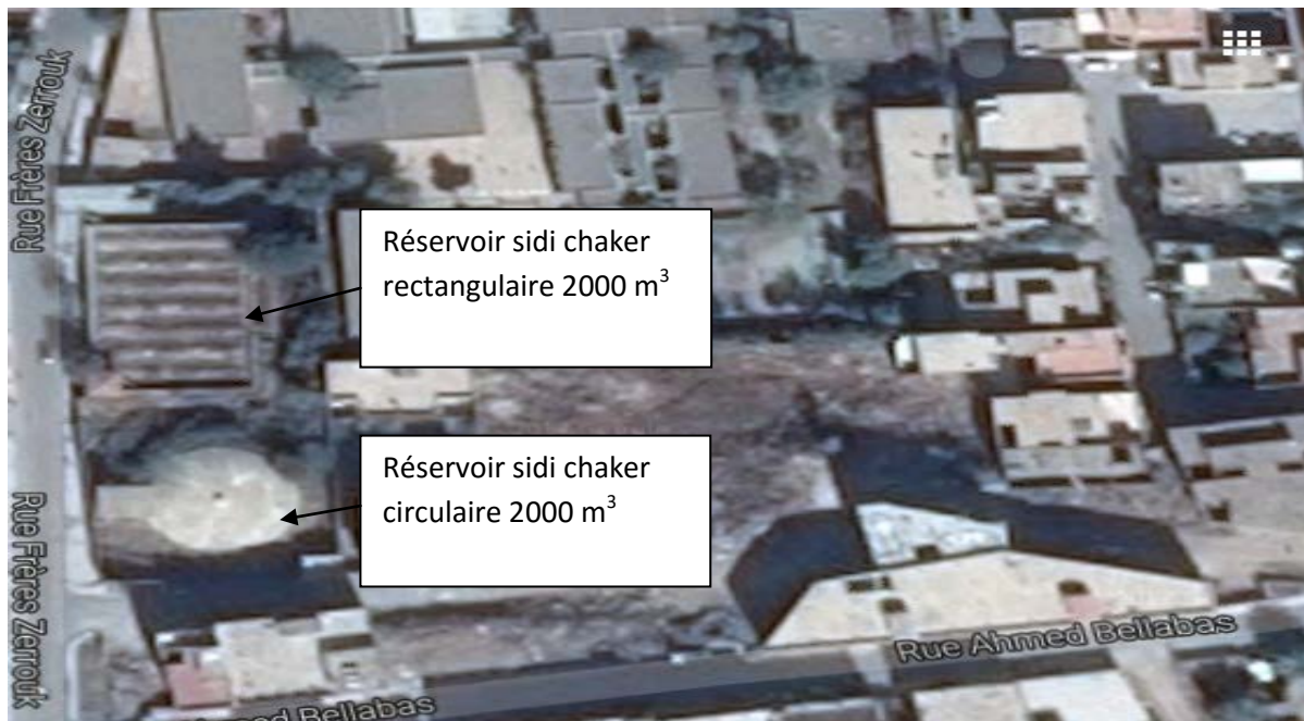
Figure II.2 : Les deux réservoirs Sidi chaker le circulaire et le rectangulaire.
