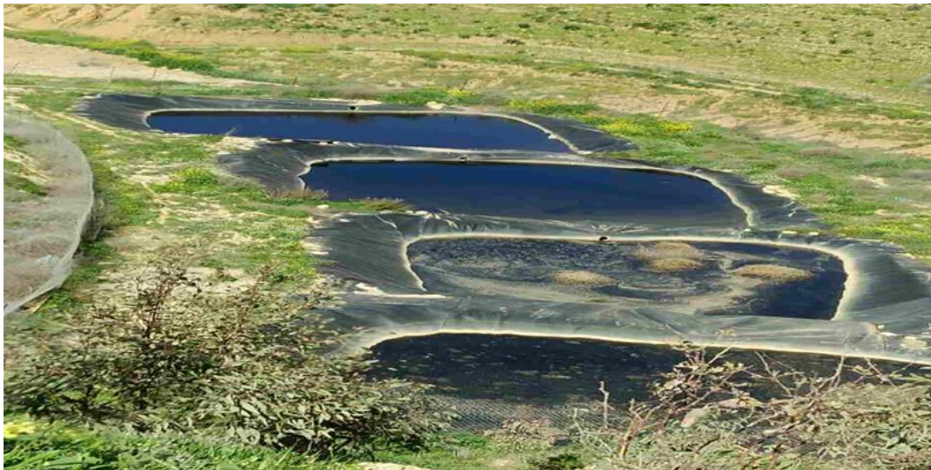
Photo 2.I.7: Lagunes du CET de Maghnia (Lokbani & Bensouna, Mars 2017)
