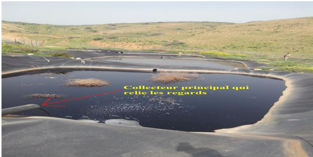
Photo 2.I.5 : Sortie du lixiviat vers les lagunes (Lokbani & Bensouna, Mars 2017)
