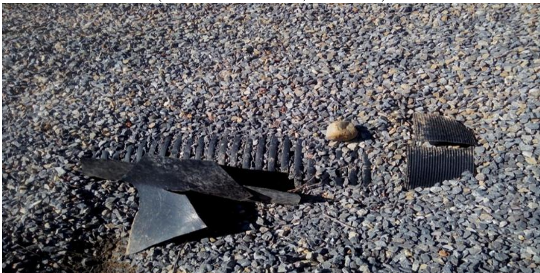
Photo 2.I.6 : Drains du lixiviat. (Lokbani & Bensouna, Mars 2017)
