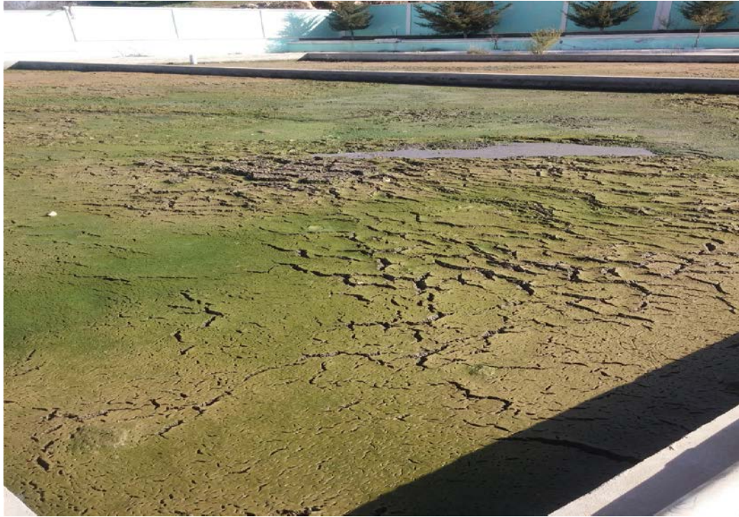
Figure III. 7 : photo d'un lit de boues en cours de séchage
