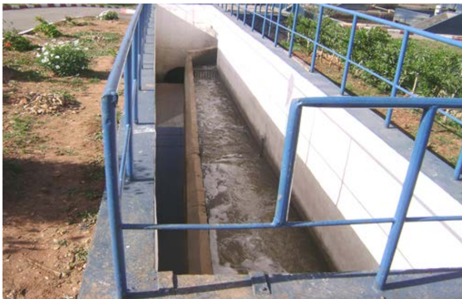
Figure III. 9: Photo du déversoir d'orage
