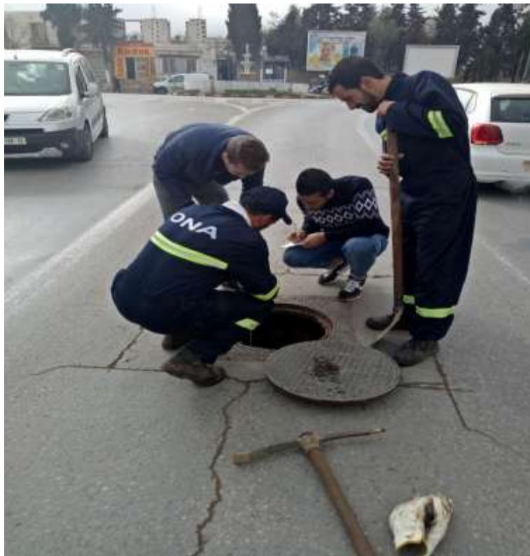
Figure III.4 : Mesure de diamètre de conduite (quartier les Cerisiers)
