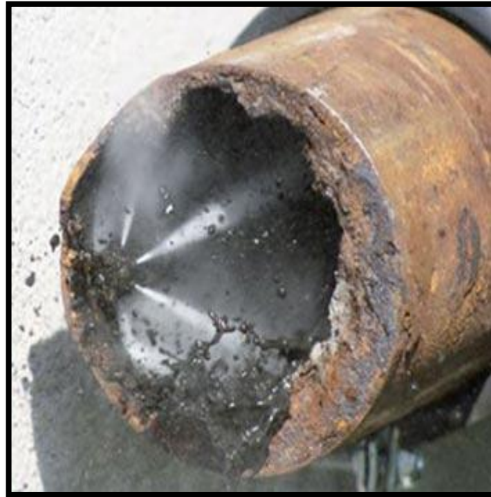
Figure. III.4 : photo de conduite curage Le curage de canalisation sur Romans. [26]
