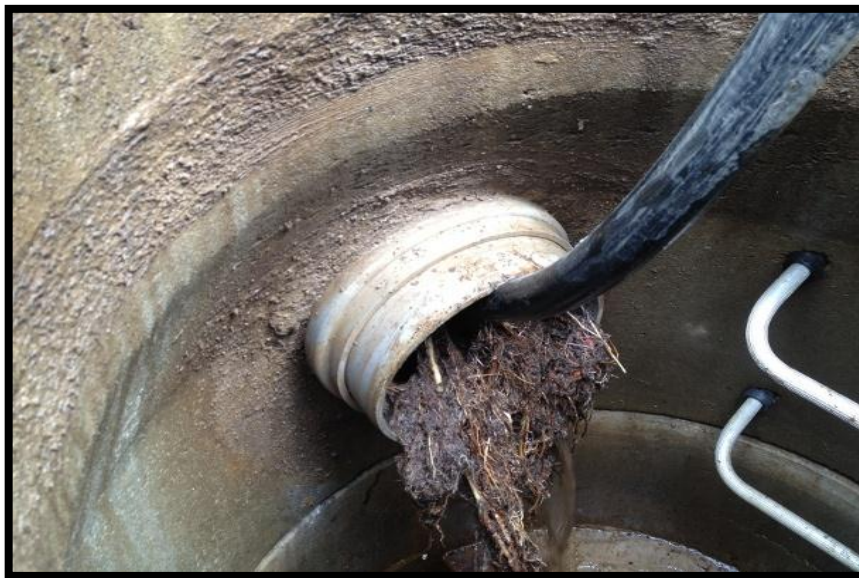
Figure .III.3 : curage de conduite [25].
