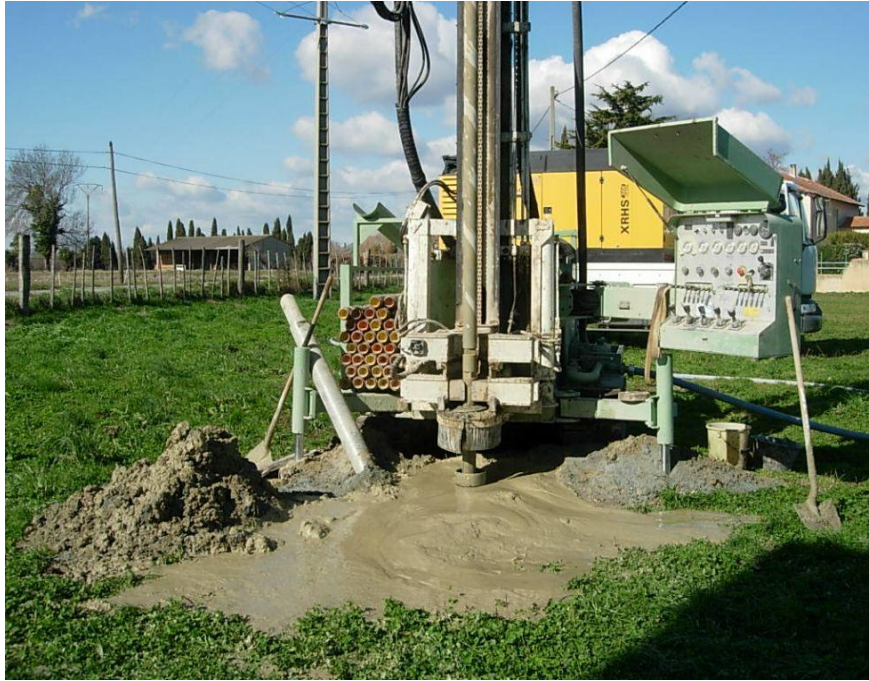
Figure I.2 : Un forage en cours de réalisation [2].
