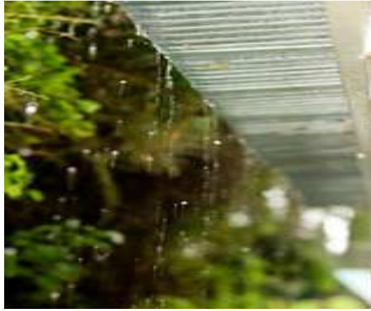
Figure 06: Les eaux pluviales
