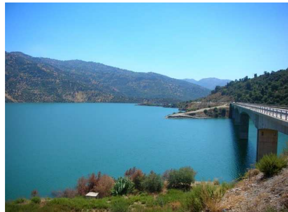
Figure. 2 : Barrage Taksebt (Tizi Ouzou)
