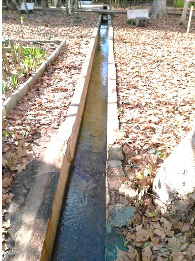
Figure III.2 : Canaux ouverts à l'intérieur du parc servant à diriger l'eau de la source vers les terres agricoles en aval (Medjahdi et Ziani, 2017)
