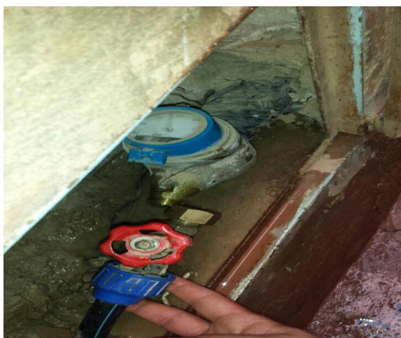
Figure V. 8 : Désassemblage de la conduite d'arrivée d'eau
