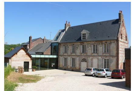
Figure28 : La transformation de la grange de Roncherolles-sur-le-Vivier en équipement scolaire
