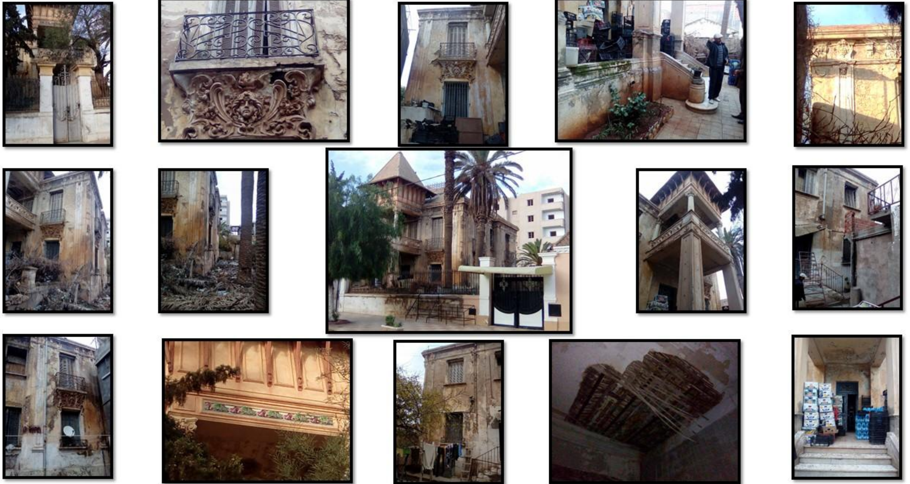
Figure 32 :Les photos de la villa Gaby intérieures et extérieures
