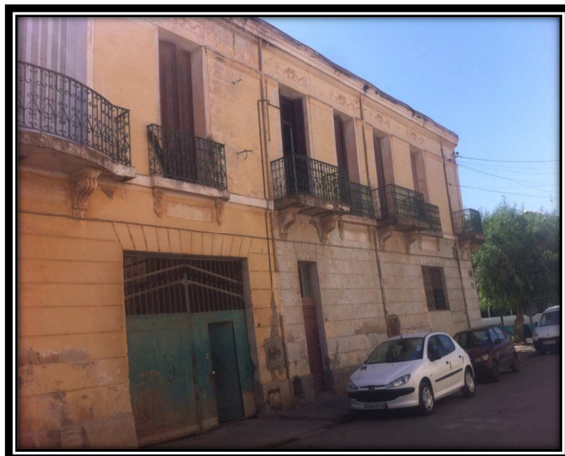
Figure 28 Poste de sécurité 1940 (source auteur)
