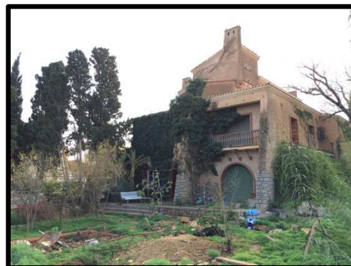
Figure 63 façade nord de la villa BOUR
