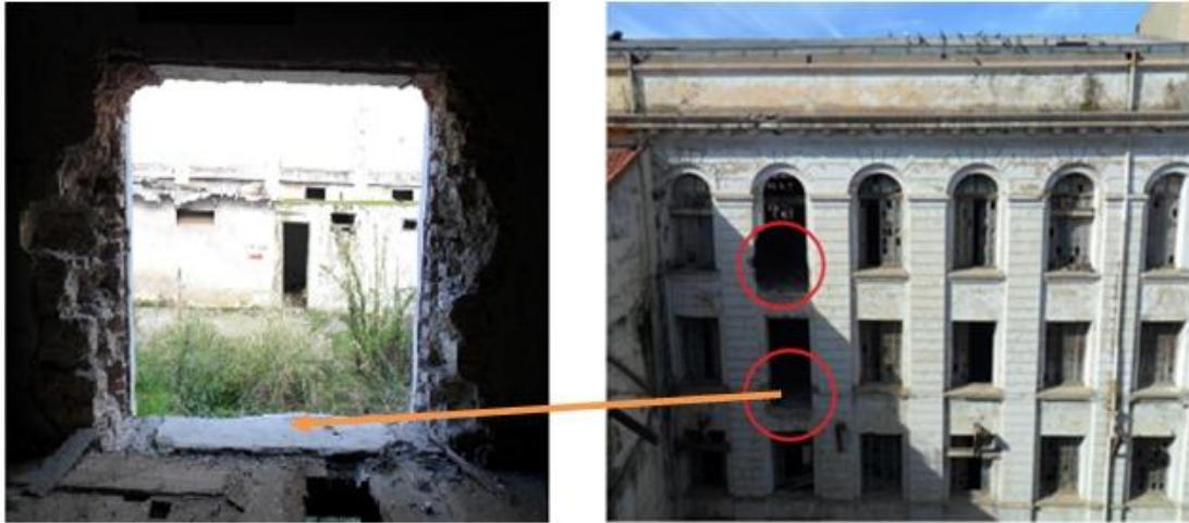
Figure 3.6 : Démolition des murs pour l'évacuation des équipements du moulin (Façade interne)
