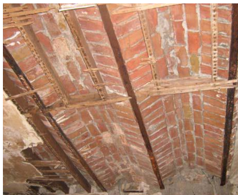
Figure 1.24: Plancher en voutain avec faux plafond
