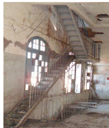
Figure 2.20 : Les escaliers métallique
