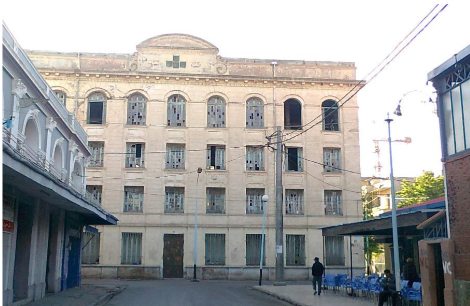
Figure 2.12: Vue de façade du bâtiment R+3
