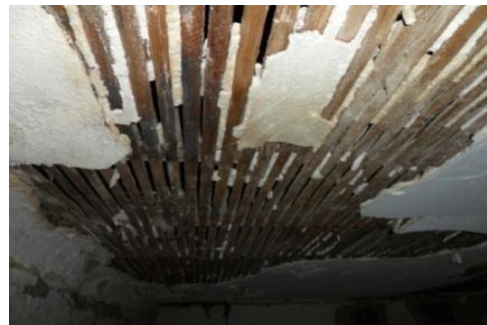
Figure 2.19 : Faux plafond en bois et plâtre
