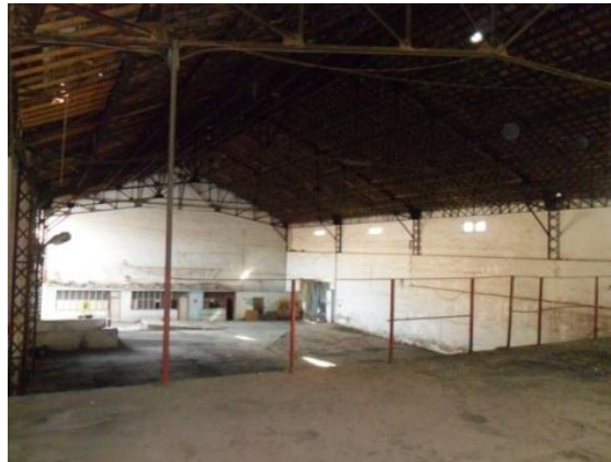
Figure 2.10: Parc des camions
