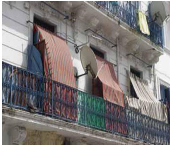
Figure 1.10 : Bâtiment: balcons filants (la Kasbah d'Alger)
