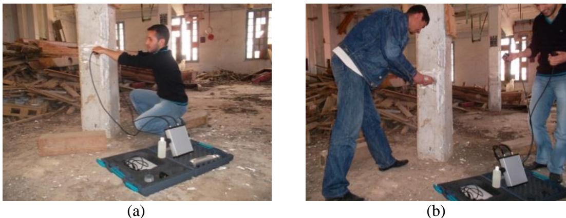
Figure 3.11 : Essais sur le béton armé
