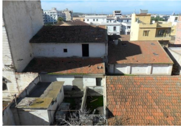
Figure 2.9: Bâtiment de sous produits
