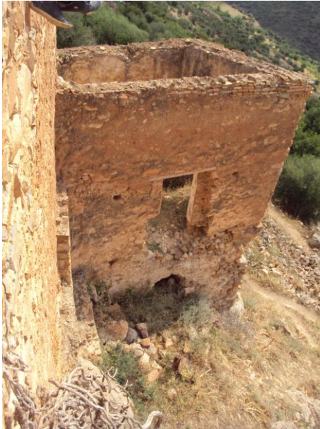
اللوحة رقم(41): مظاهر تلف الرحي رقم 2 من أرحية واد الصفصيف
