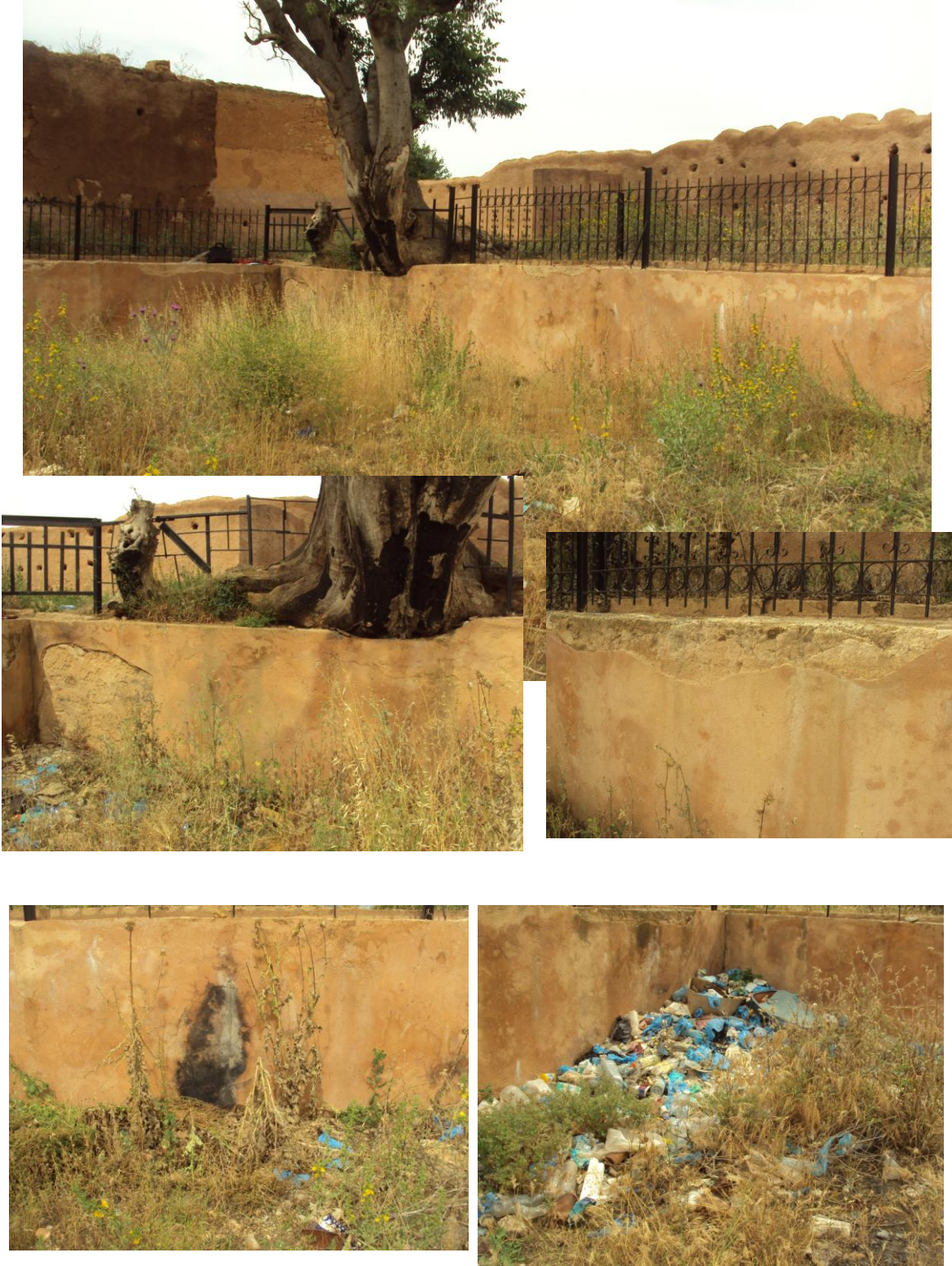
اللوحة رقم(34): مظاهر التلّف اللاحقة بالصهرج الشرقي للمنصورة
