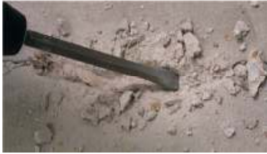
a-Ouverture des fissures
