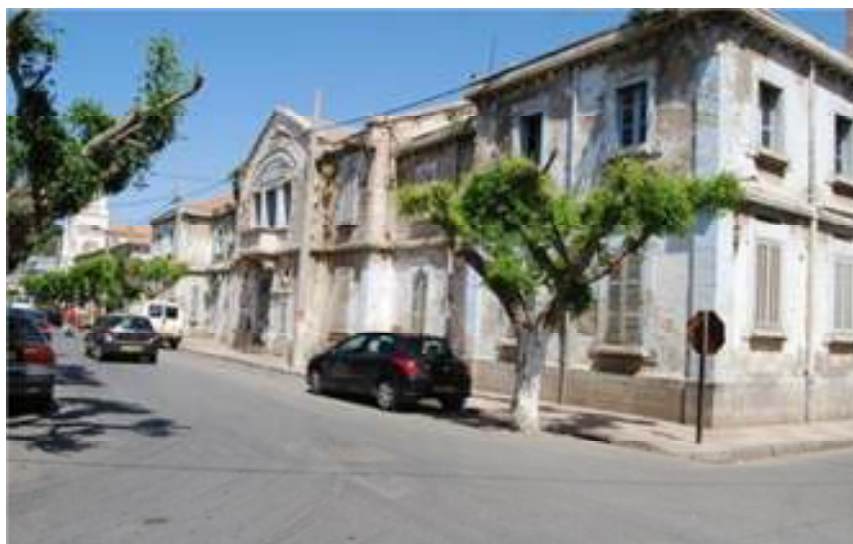
Figure2.1 : vue globale du bâtiment
