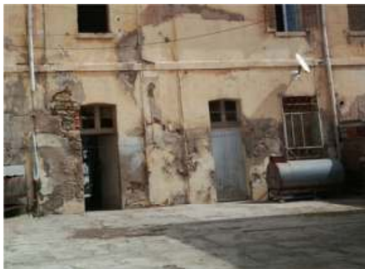
Figure 4.11 : réparation de la cour
