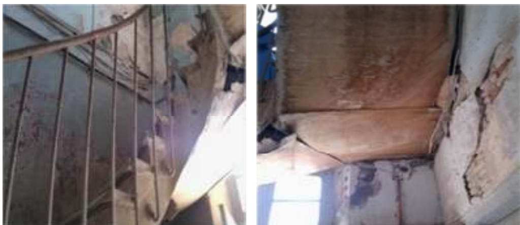
Photos 3.7: la cage d'escalier
