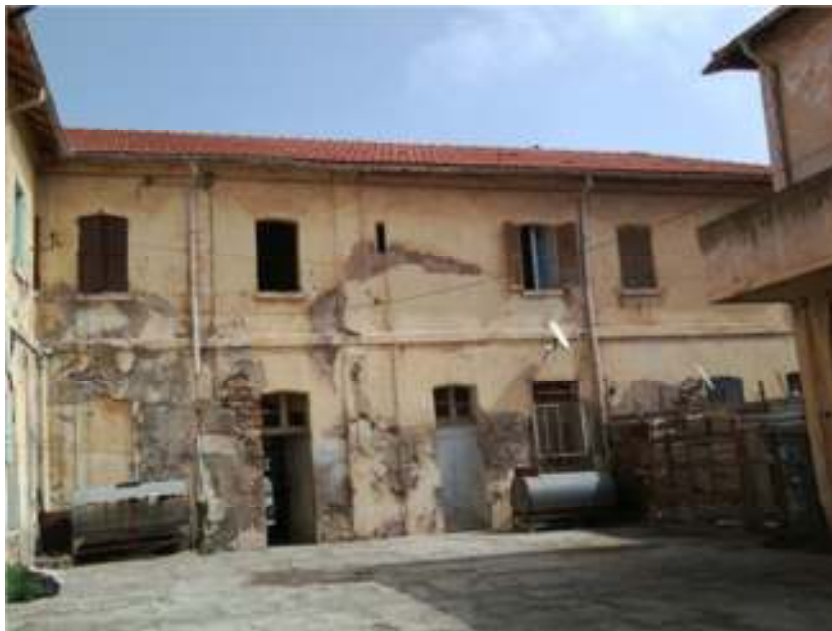
Photo 3.7 : la cour intérieure
