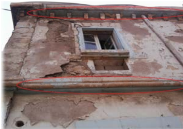
Figure 2.14 : couronnement et corniche.
