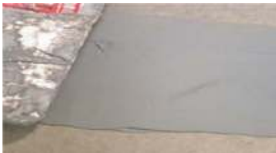
e-Lissage de finition de calfeutrement
