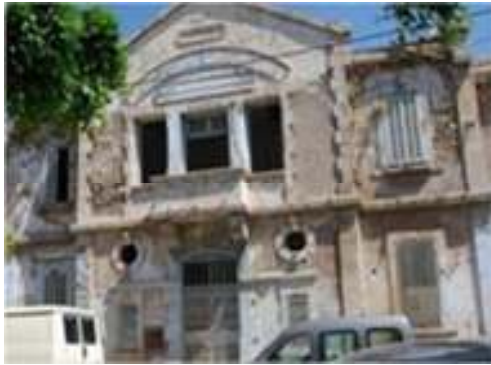
a-Façade principale (bloc B)
