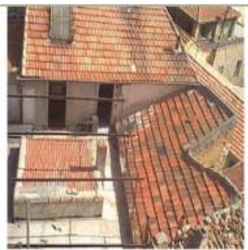
b-dégradation d'étanchéité
