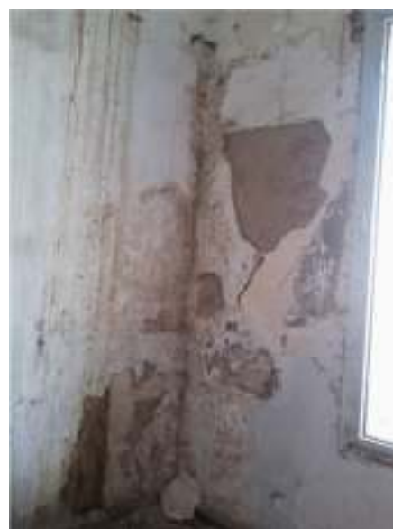
d-mur intérieur dans le bloc B
