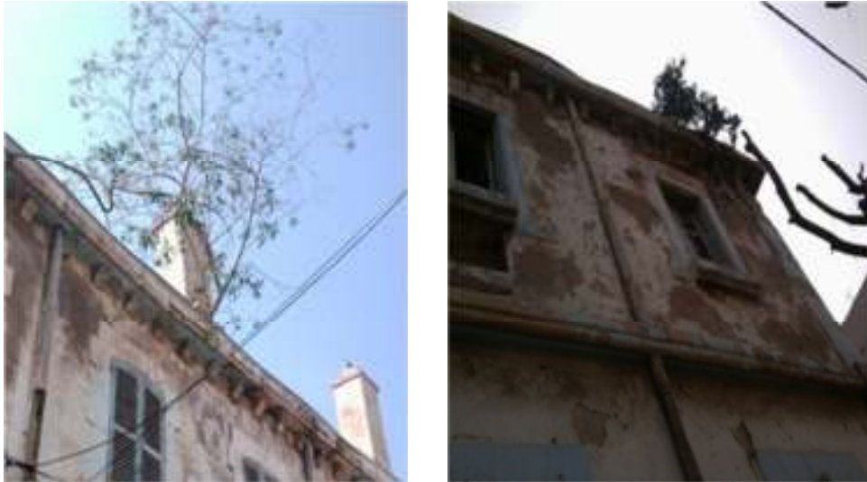
Photos 3.6: la végétation sur les toitures
