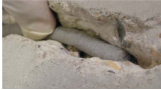
b-Mise en place du fond du joint
