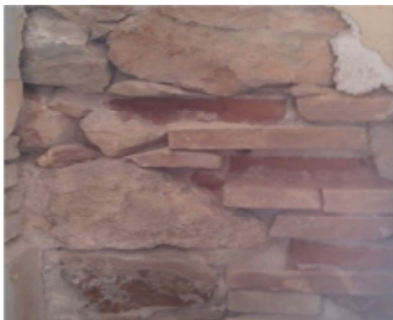
figure4.6 : rejointoiement de mortier d'hourdage
