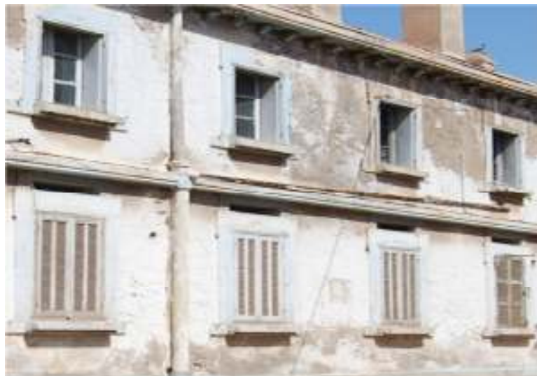
Figure 2.17 : les appuis de fenêtres
