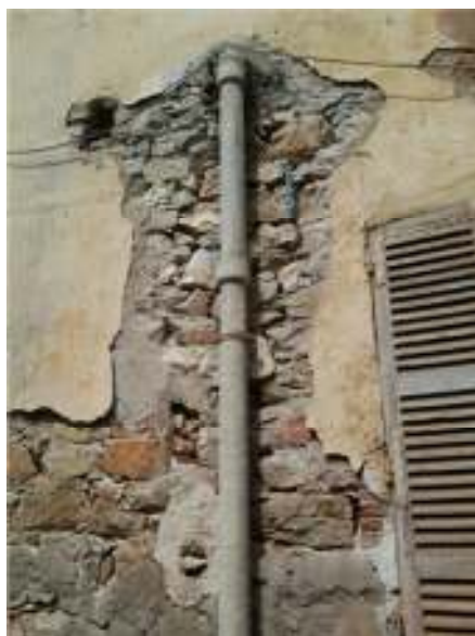
c-mur extérieur de la cour
