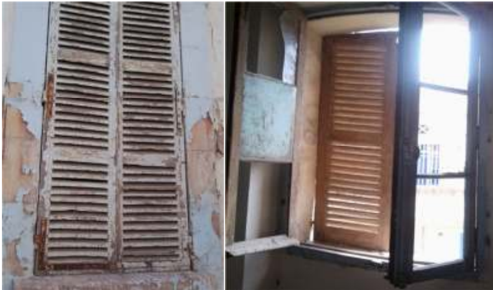
Figure 4.13 : réparation des éléments de menuiserie dégradés
