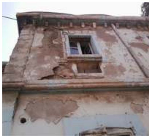
b-mur extérieur du bloc B.
