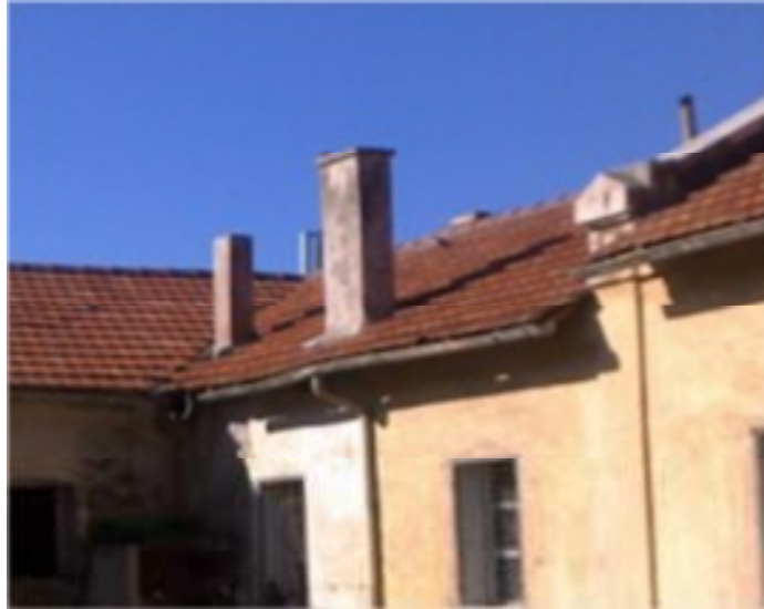
Photo 3.11 : les type de cheminé sur le bâtiment
