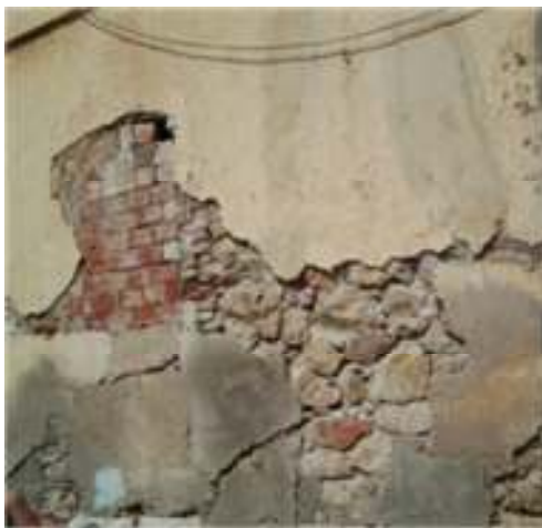
a-murs face de la cour.
