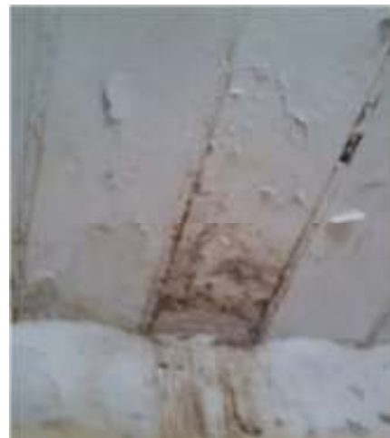
b- oxydation ponctuelle avancée.
