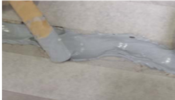
d-Réalisation d'un calfeutrement
