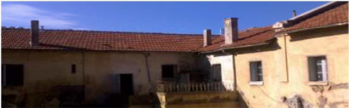
Figure 4.14 : charpente de Toiture
