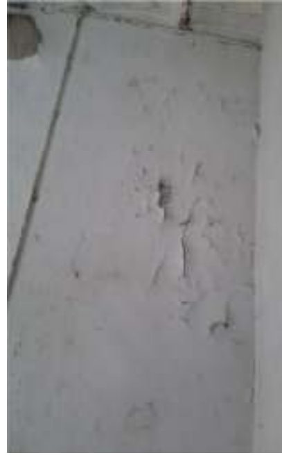
b- mur intérieur
