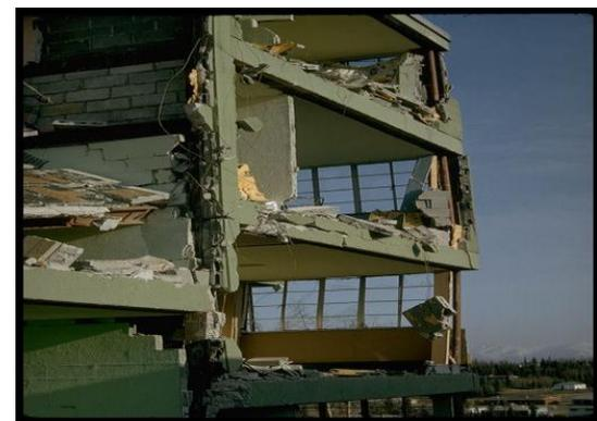
Fig. II.19 : Dislocation des remplissages de maçonnerie.
