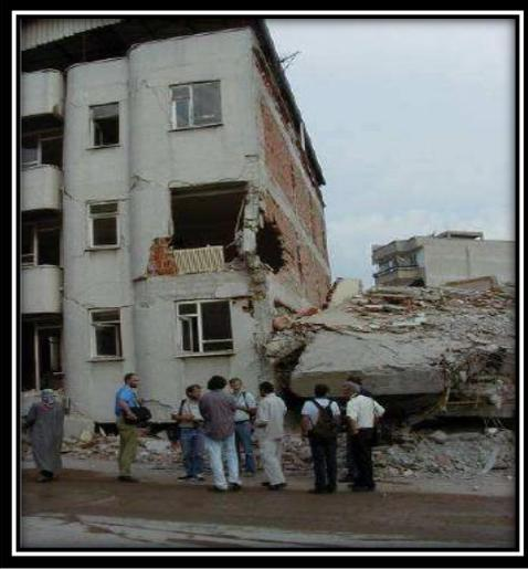
Fig. II.1: Effondrement du bâtiment de droite et interaction avec le bâtiment mitoyen.
