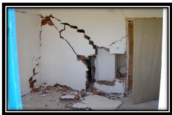
Fig. II.20 : Destruction des panneaux.
