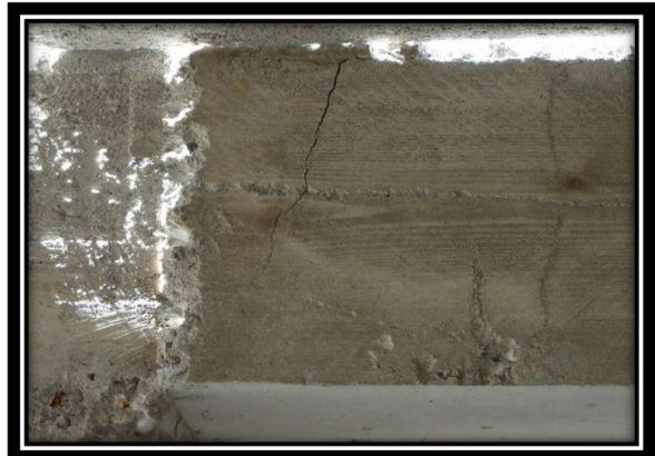
Fig. II.14 : Fissures inclinées dues aux effets de l'effort tranchant.
