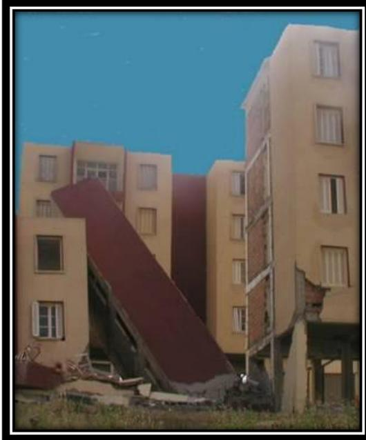
Fig. II.5 : Largeur de joint insuffisante, effondrement complet du bloc après entrechoquement.
