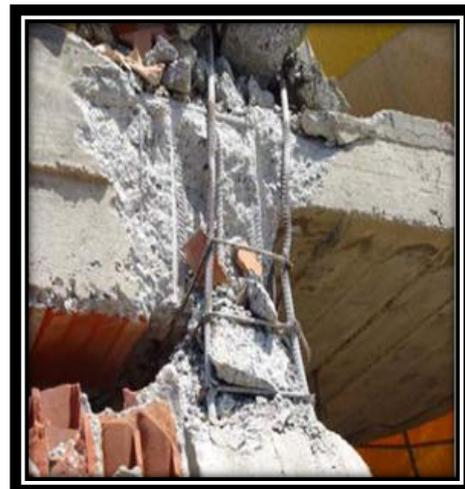
Fig. I.6: Effondrement à cause de l'absence d'armatures transversales dans le nœud et dans la zone critique du poteau.
