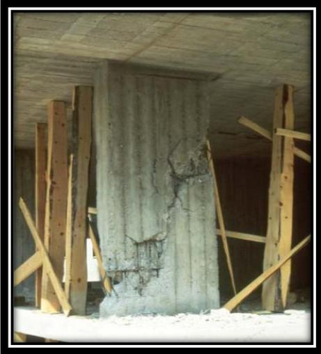
Fig. 2.21 : Rupture en diagonale.
