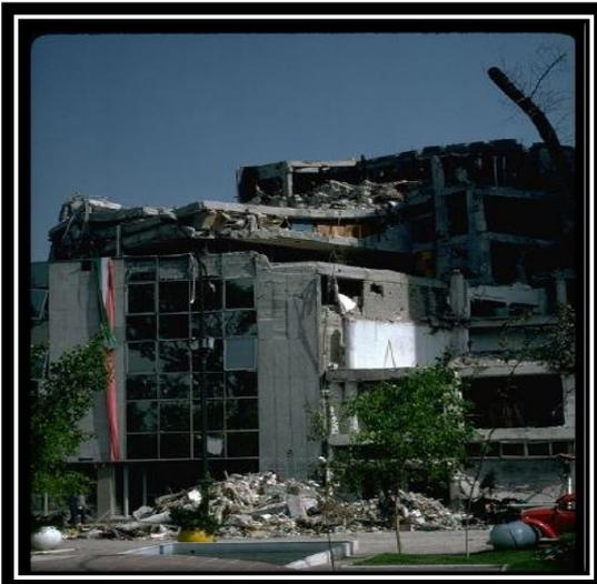
Fig. II.3 : Coup de fouet dans les étages supérieurs d'une construction.
