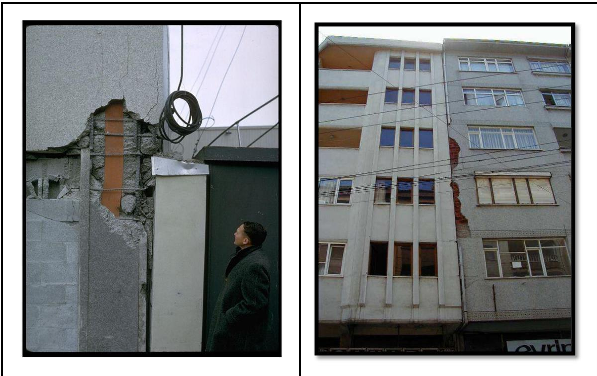
Fig. I.7: Entrechoquement de bâtiments voisins séparés par un joint de dilatation.
