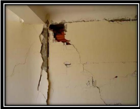
Fig. II.17 : Écrasement de l'angle comprimé.
