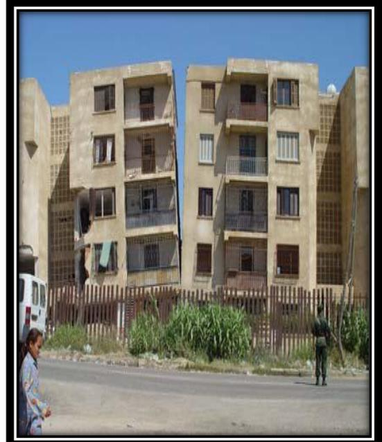
Fig. II.6 : Basculement des bâtiments après entrechoquement.
