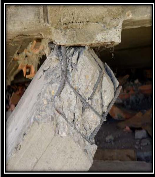
Fig. II.9 : Rupture au droit de la surface de reprise de bétonnages, insuffisance d'armatures transversales, béton de mauvaise qualité.
