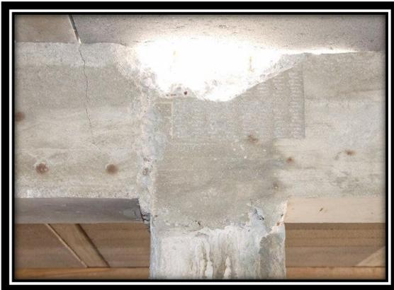
Fig. II.13 : Fissure aux niveaux de la zone nodale
