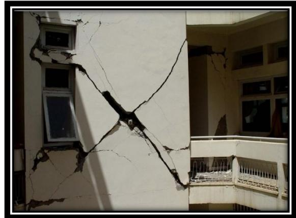
Fig. II.18 : Fissurations en X aux niveaux de la maçonnerie.
