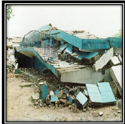
Fig. II.4 : Effondrement en « mille-feuilles » des planchers d'une construction.
