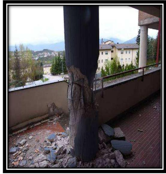
Fig. II.8 : Endommagement de poteaux courts par cisaillement et un manque des armatures transversales.
