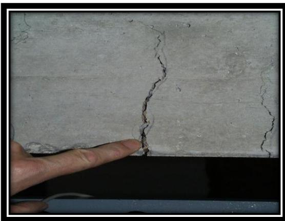
Fig. II.15 : Fissures à mi travée.
