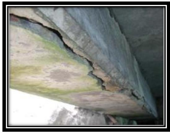
Fig. II.16 : Fissure due a la corrosion des armatures.
