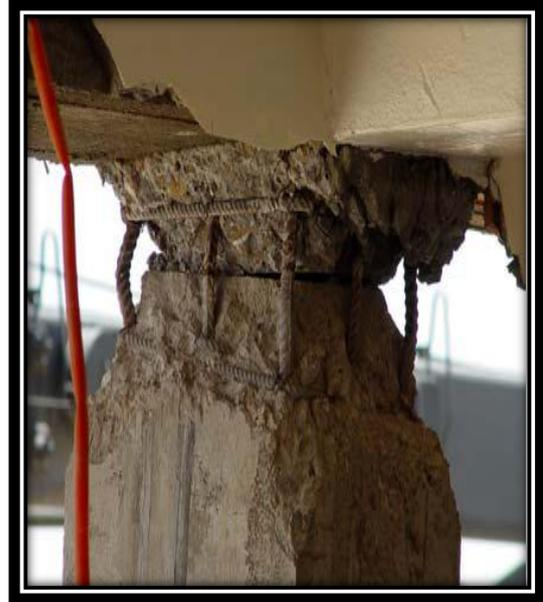
Fig. II.10 : Destruction de l'extrémité du poteau du fait de l'absence d'armatures transversales et de la présence de la talonnette.
