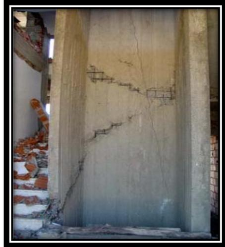
Fig. 2.22 : Fissure critique diagonale.
