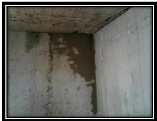
Fig. II.23 : Fissure très importante au niveau du plancher
