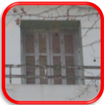
Fenêtre de la période coloniale
