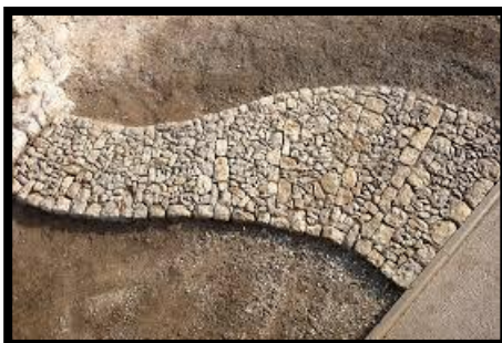
Figure :Revêtement du sol. Source: www.arc-en-
