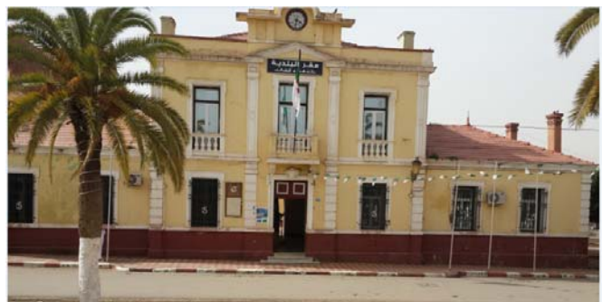
Figure 28: photos de la mairie
