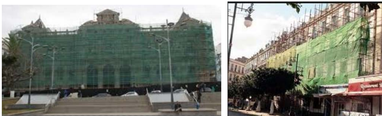
Figure 16: Photos des chantiers de réhabilitation à Oran,
