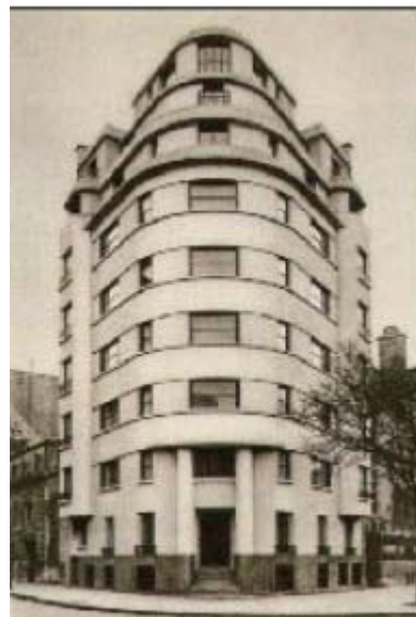
Figure 10:Façade immeuble 128 rue brémontier pierre batout 1929
