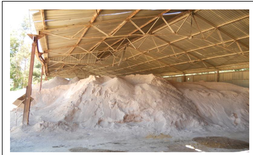
Figure 1.1 stockage des granulats
