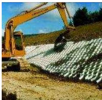
a. Géotextile tridimensionnel type Armater
