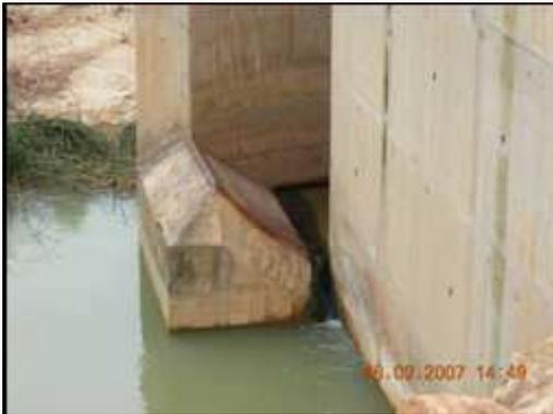
Source de sortie du sédiment de dragage
