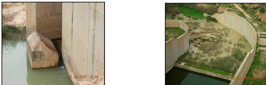
Figure.4. Source de sortie et zone d'accumulation du sédiment sur le coté aval du barrage Cheurfas
