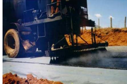
Géosynthétiques dans la construction d'une chaussée
