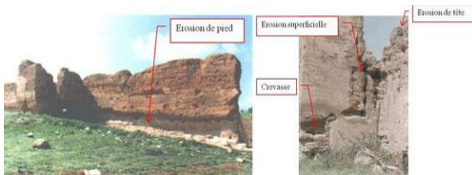
Photo 3.4 : Les différentes pathologies recensées sur les remparts en pisé du site historique de Mansourah
