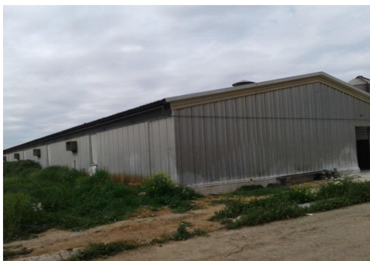
Figure 3.4 Le bâtiment d'élevage (Photo source personnelle)
