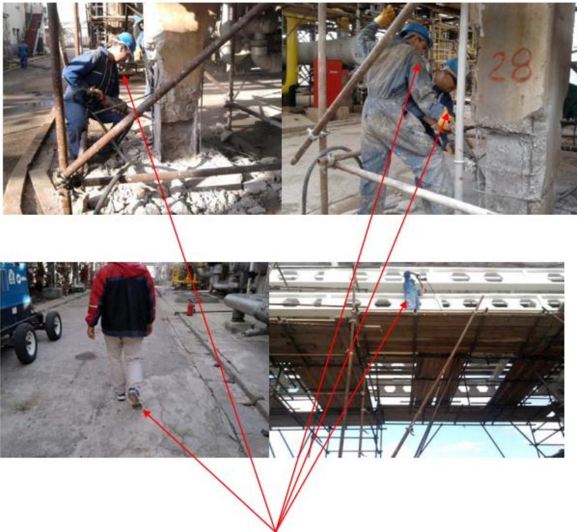
Figure III.7 : Absence d'utilisation des moyens de protection individuelle (EPI : lunettes, masques à poussière, soulier et ceinture de sécurité) [41].
