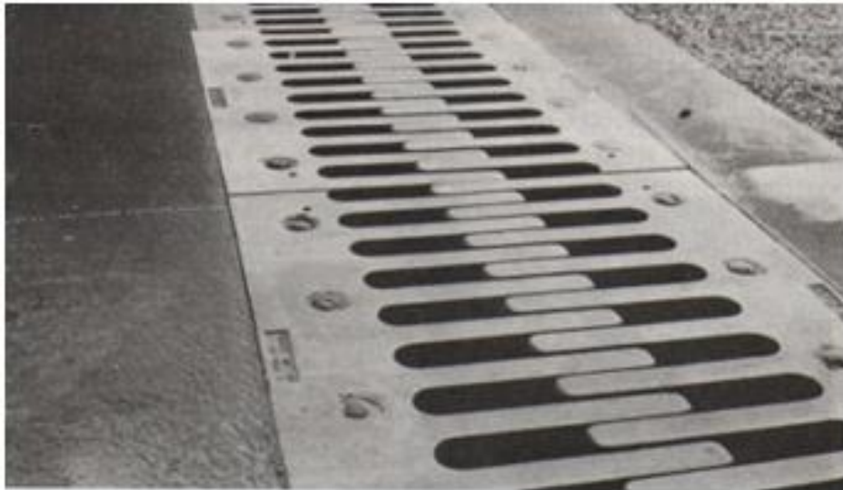
Figure 7-11 : Joint de chaussée
