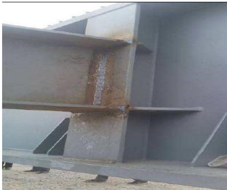
Figure 7-1 : Assemblage de deux profilées reconstitués soudées
