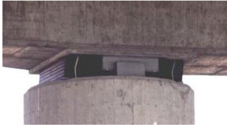
Figure 7-1 : Photo réelle d'un appareil d'appuis
