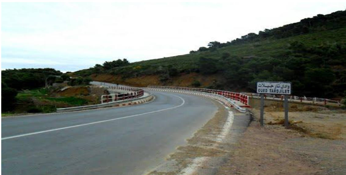
Figure 2-2 : Vue réel du pont (photo prise le 29/04/2012).
