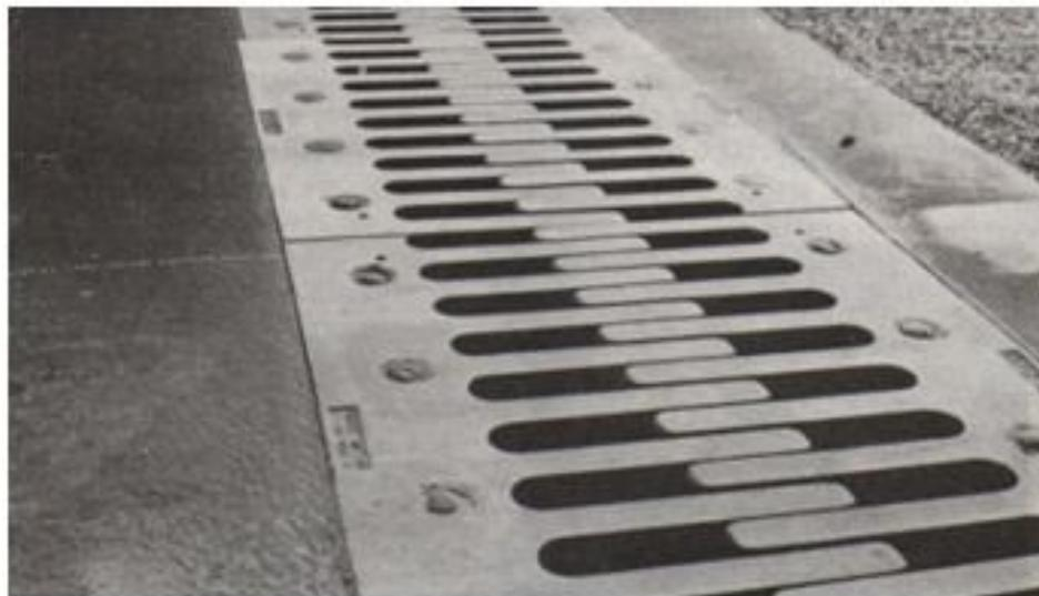
**Figure V.11 : Joint de chaussée**
