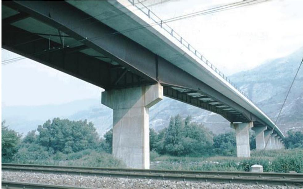
Figure I.7 : un exemple de pont mixte bipoutre
