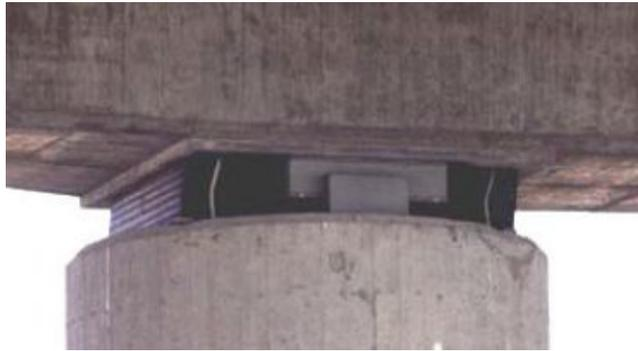
Figure V.1 : Photo réelle d'un appareil d'appuis
