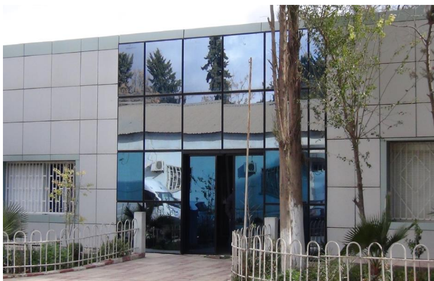
Figure 3.1. Siège de l'entreprise STARR
