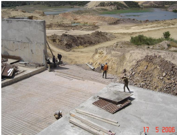
Figure 3.3. Travaux terrassement cite Djamel –Oran et Bétons hydrauliques pour un petit barrage EL-ABED
