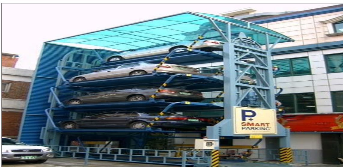
Figure 1.4 : Parking automatisé doubler l'emplacement. [7]
