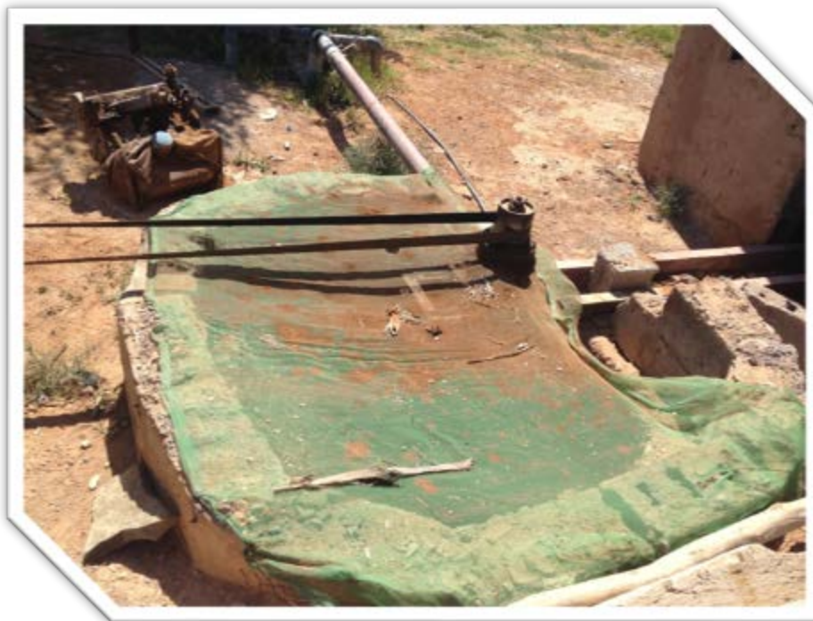
FigureIV.8 : Un forage de 27 m de profondeur. [28]
