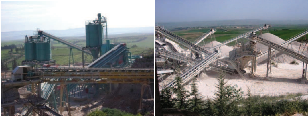
Figure II.9. Vue Générale de la station de Sidi Abdelli
