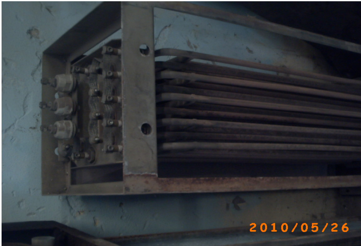
Figure (I.2): L'évaporateur de l'installation.
