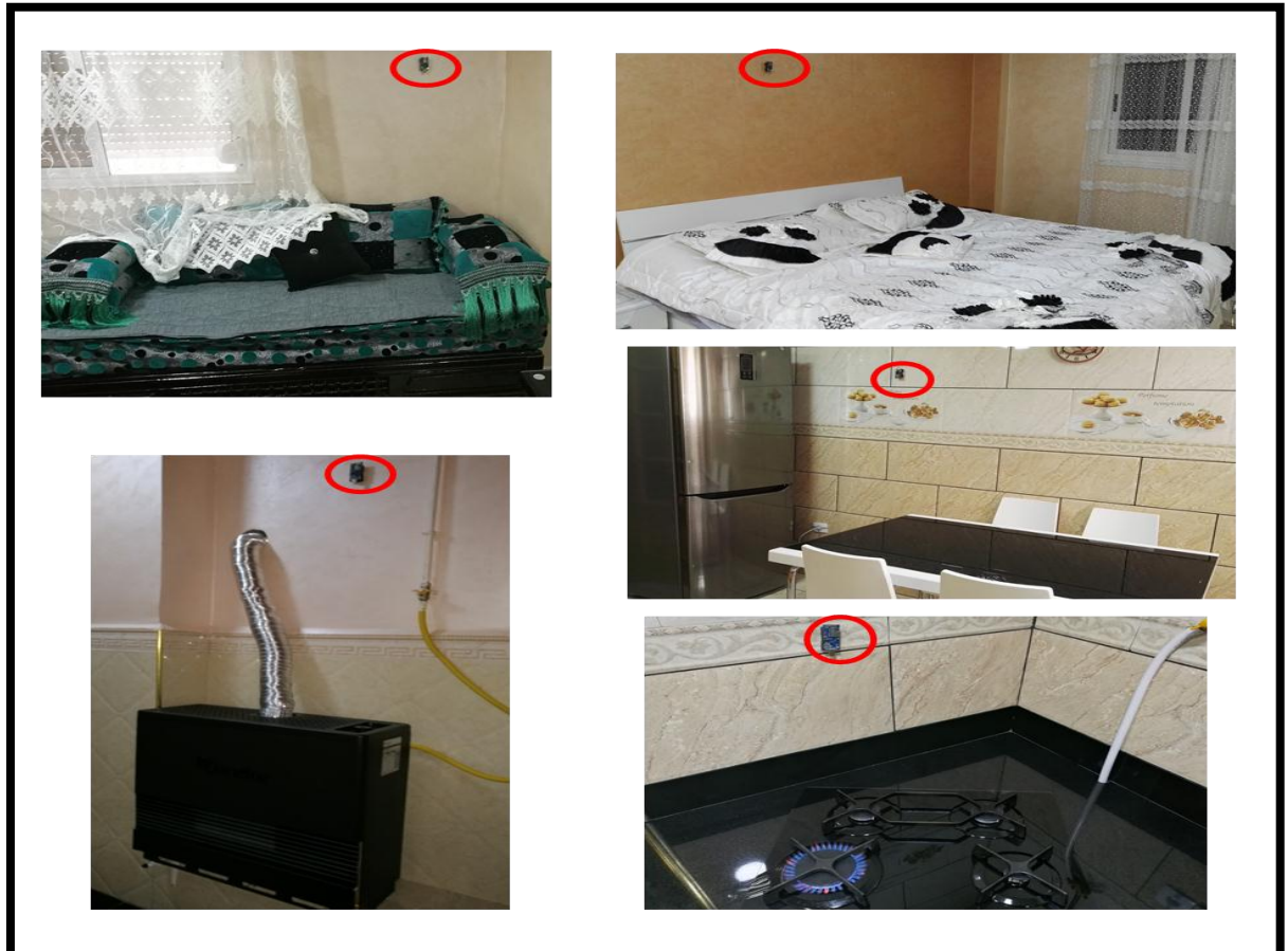
Figure IV.14 : le déploiement des capteurs dans une maison
