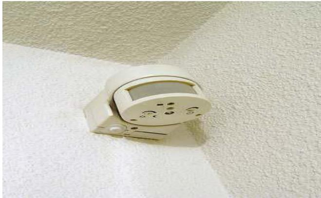
**Figure 22 :** Détecteur de mouvement s'intègre à un système de protection. © Zigazou76, CC BY 2.0, Flicker
