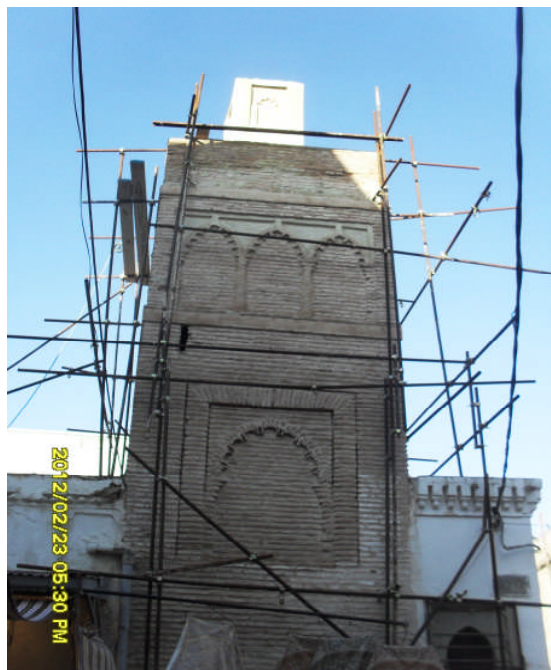
Fig.85 : Minaret de la Mosquée de Sidi El Benna façade Ouest
