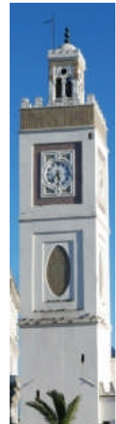
Fig.65 :le minaret de Djamaa djedid
