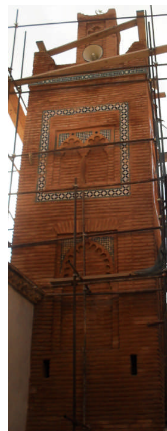
Fig.82: Minaret Mosquée d'Awlad Al-Imam. Façade Sud
