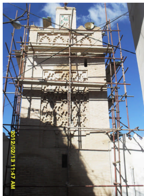
Fig. 87. minaret de la Mosquée de Sidi Lahcène .façade Sud
