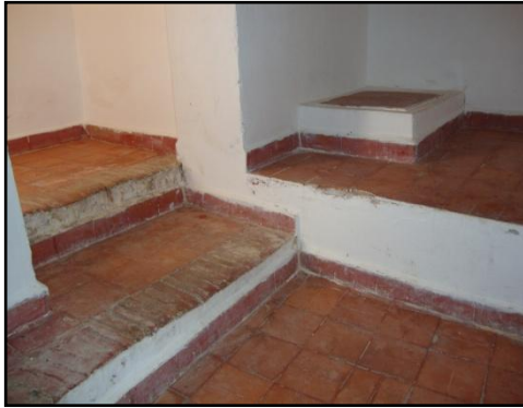
Fig. 131: A- Revêtement en terre cuite.
