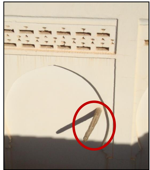
Fig. 116: Tirants en rondins de bois ancrés ans le mur.
