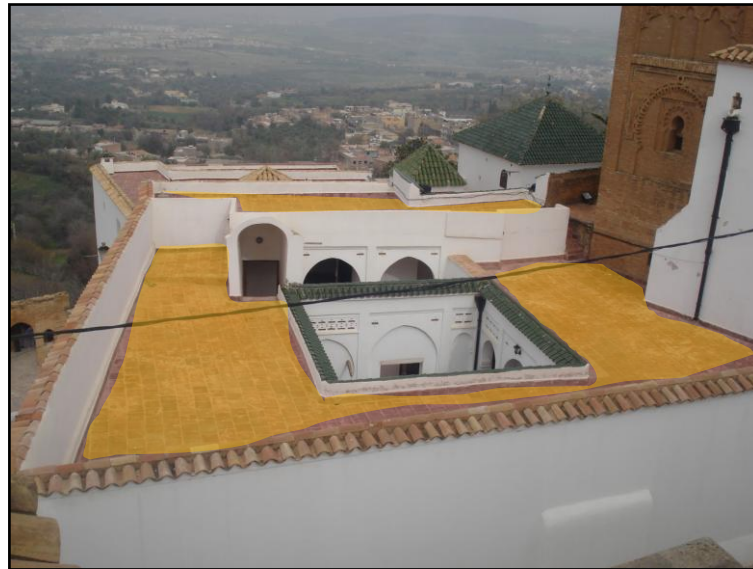
Fig. 112: Terrasses de la maison. Source: Auteur.
