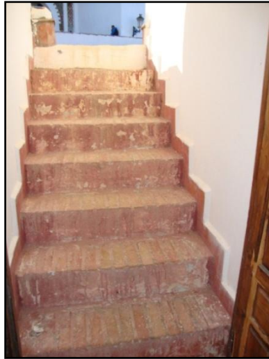
Fig. 119: Escaliers. Source: Auteur.
