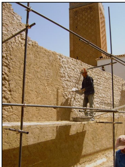
Fig. 140: Reprise des enduits. Source: BET ATTAR.
