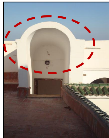
Fig. 132: La voûte en berceau et enduit de chaux. Source : Auteur.
