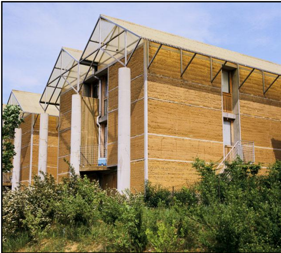
Fig. 64: logements en pisé au domaine de la terre.
