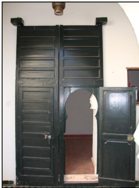
Fig. 134: Porte de la chambre en bois. Source : Auteur.
