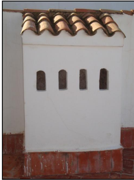
Fig. 135: Cheminée au niveau de la terrasse. Source: Auteur.
