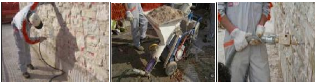
Fig. 85: A- Nettoyage des trous par soufflage d'air comprimé en suite par humidification. B- Machine de pompe d'injection. C- Injection du coulis de chaux.
