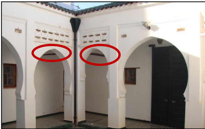
Fig. 116: Tirants en rondins de bois ancrés ans le mur.
