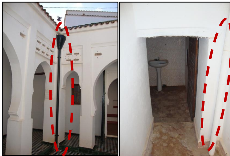
Fig. 136: Evacuation des eaux pluviales. Source: Auteur
