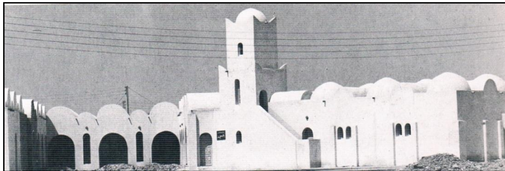
Fig. 63: Nouveau village agricole de Maadher, près de M'sila en Algérie construit en parpaings de terre stabilisée en 1980 par deux architectes, les frères El Miniaway.
