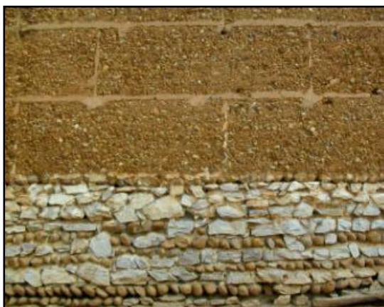
Fig. 68: Présence de cordons de mortier de chaux entre lit+ Soubassement en pierre(France).
