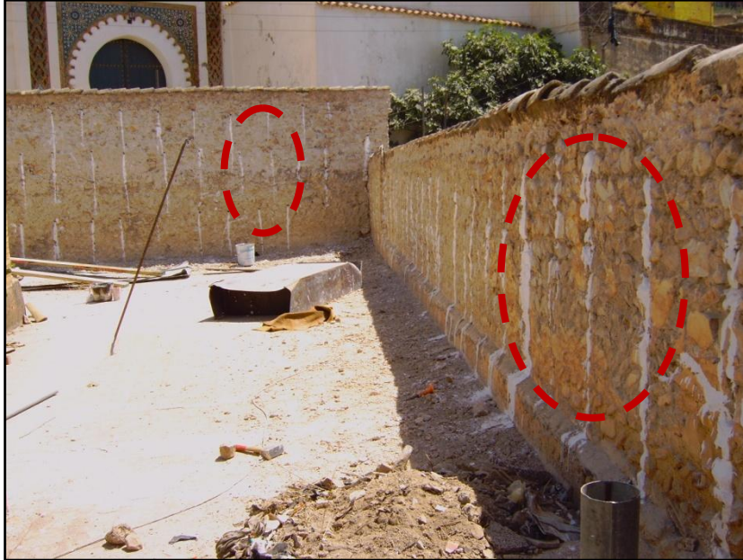
Fig. 143: Injection de coulis de chaux. Source: Auteur
