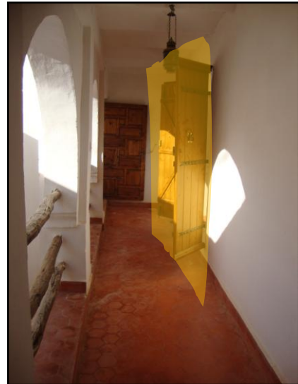
Fig. 110: Ouverture de la chambre sur la galerie de l'étage.
