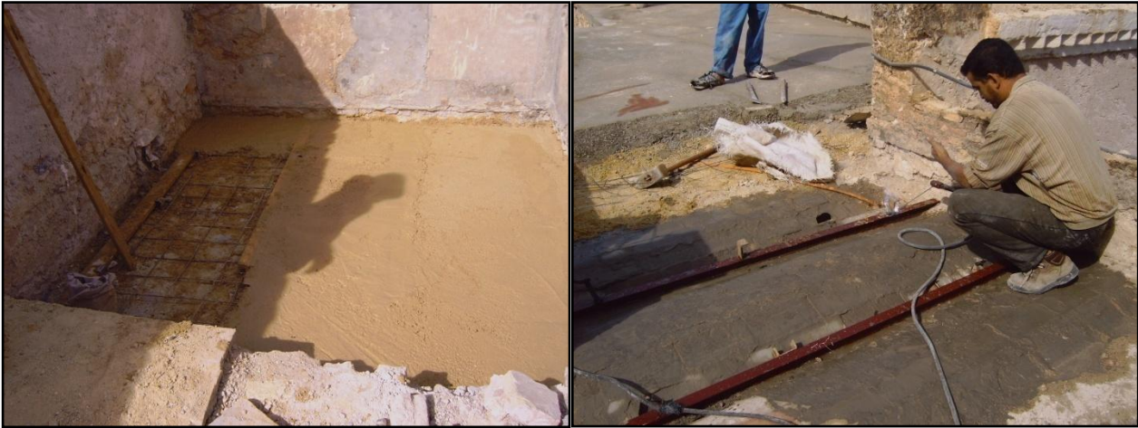
Fig. 141: Coulage de la chape de terre et de la chape de béton. Source: Auteur
