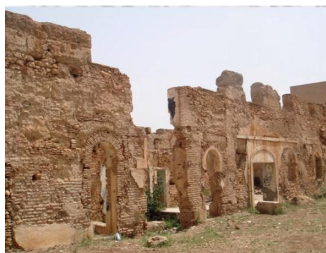
Photo n°49: le palais al-machouar Avant l'intervention
