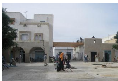
Fig 5 : Au cours des travaux
