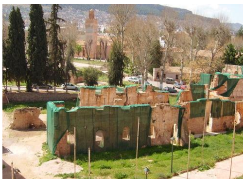
Photo n°48 : le palais al-machouar Avant l'intervention
