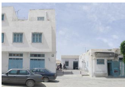
Fig 4 : Avant les travaux
