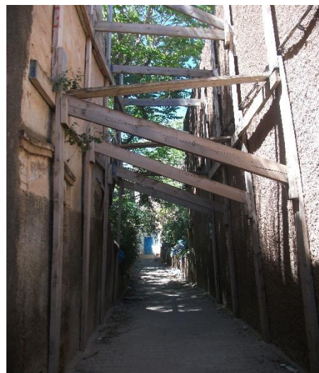
Photo n°55: consolidation d'une maison, intervention APC (source : auteur, 2015)
