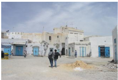
Fig 7 : Au cours des travaux
