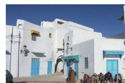
Fig 9 : Avant les travaux
