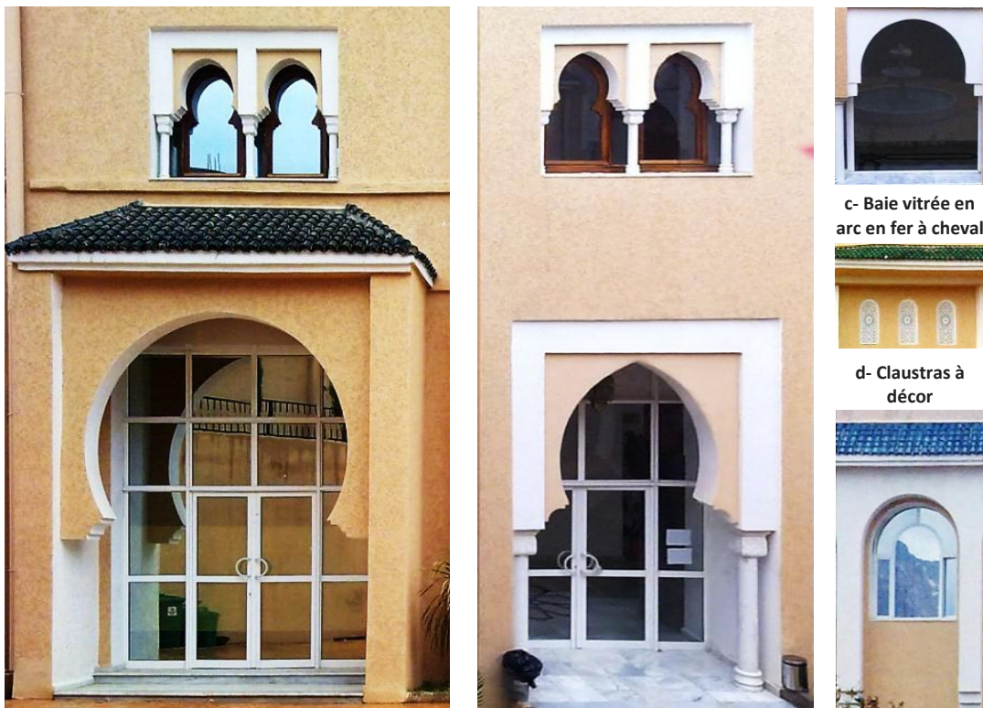
a- Au-dessus : Fenêtre à arcs brisés outrepassés gémérés. En dessous : porte en avant-corps en arc en fer à cheval
