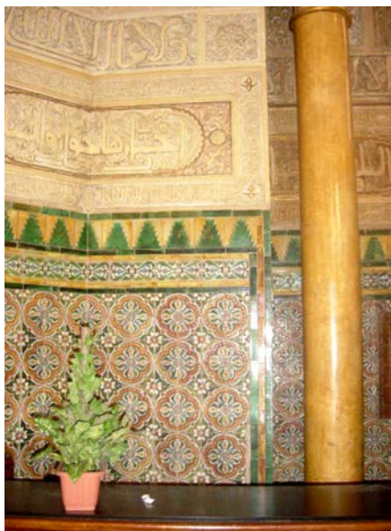
b- Revêtement des murs intérieurs
