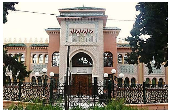
Figure 38 : Façade principale de l'Institut Islamique d'Imama (Source_2015 : fr.alltravels.com).
