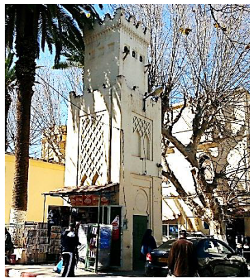
Figure 1 : Poste transformateur (actuellement kiosque) Place des Martyrs – Tlemcen (Source_2016 : Auteur).
