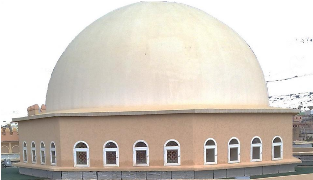
Figure 52 : Dôme en demi-sphère sur tambour octogonal ajouré (Source_2015 : Auteur).
