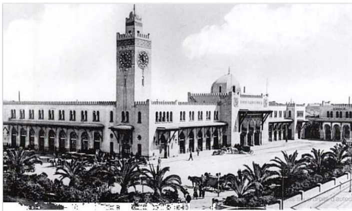
a- Gare d'Oran (1913), dessinée par l'architecte Albert Ballu et construite par l'entreprise des frères Perret. Son aspect extérieur est celui d'une mosquée, où l'horloge a la forme d'un minaret (Source : OULEBSIR N., 2004, p.257).
