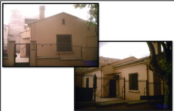
Photo 68: maison dans quartier Bel Air
