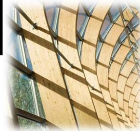
Le **lamellé-collé** ou **bois lamellé** est un procédé de fabrication consistant à coller des lamelles, généralement de bois, avec les fibres du matériau dans le même sens.
